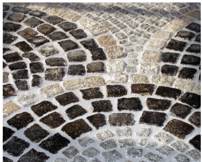
6 Fertig verfugter Belag.
