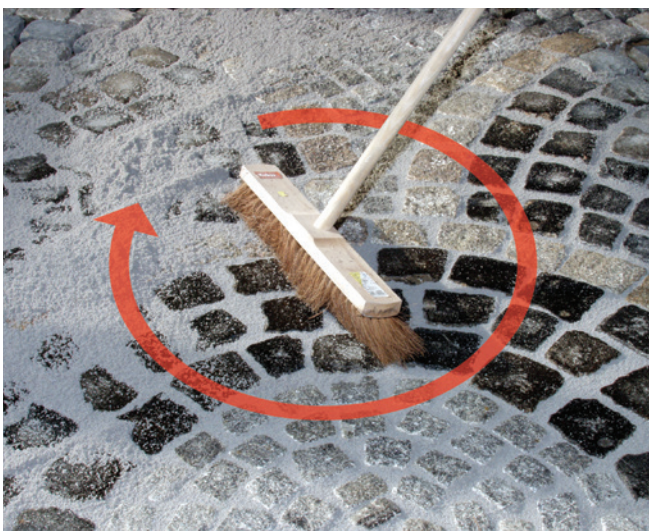
5 Säubern des verfugten Belags.
