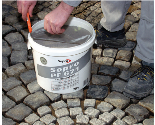
2 Öffnen der Vakuumfolie von Sopro 1-K PflasterFuge.
