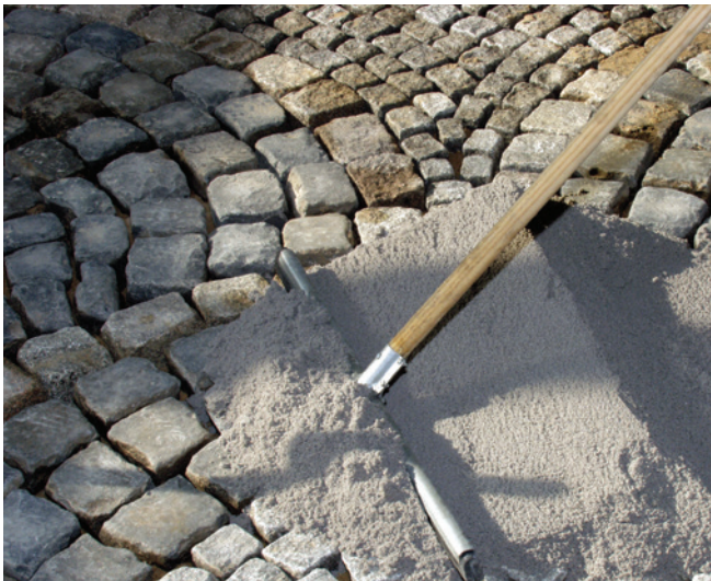
3 Fugenfüllendes Einbringen von Sopro 1-K PflasterFuge.
