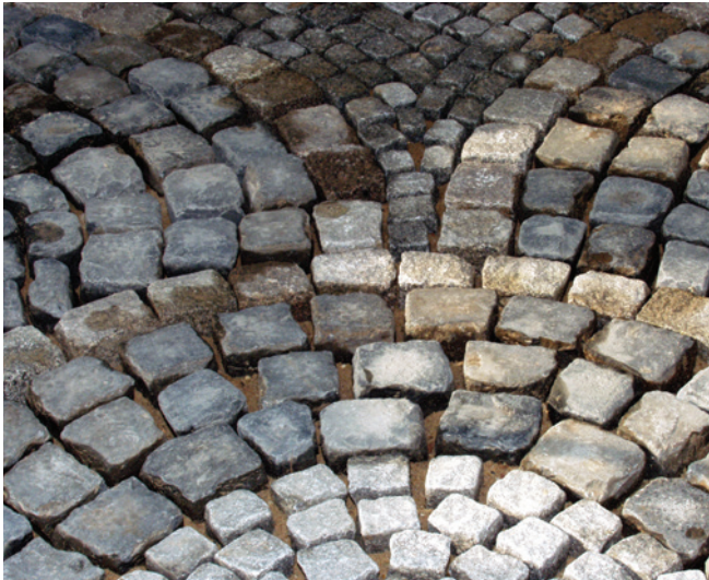
1 Gereinigter, trockener, zu verfugender Belag.
